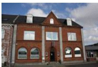
Jernbanegade 1: Renovering af facade og kviste samt udskiftning af hoveddør og vinduer.
