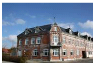
Jernbanegade 5: Renovering af facade
