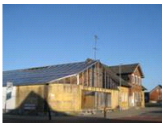
Søndergade 7: Renovering af facade samt nedrivning af nedlagt gartneri
