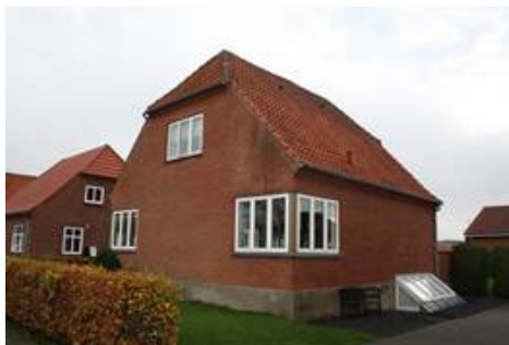
Nygade 11: Udskiftning af tag. Renovering af fugtskadedt murværk.
