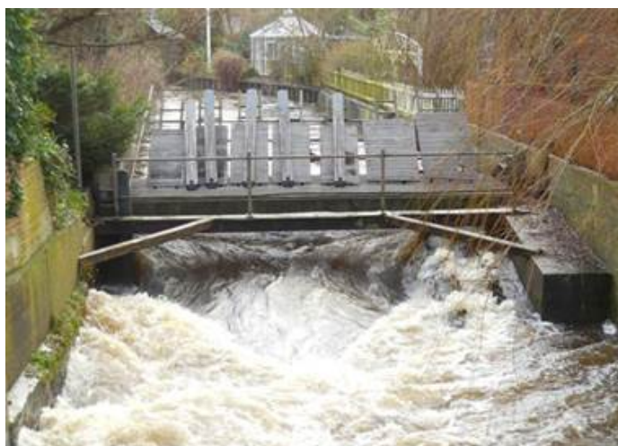
Figur 1. Frislusen med alle 6 skytter og alle 5 poster trukket, under stor afstrømning, 24.12.2014.
