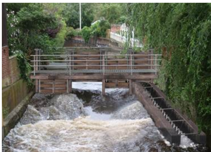
Figur 2. Visualisering af et automatiseret stemmeværk. Fisketrappen er placeret længere t.h., og er forlænget.
