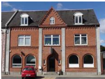
Jernbanegade 1: Udskiftning af tag.
